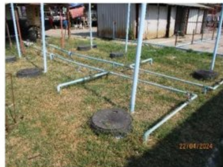
รูปที่ 2-33 ถังบำบัดน้ำเสียสำเร็จรูป บริเวณบ้านพักคนงาน
