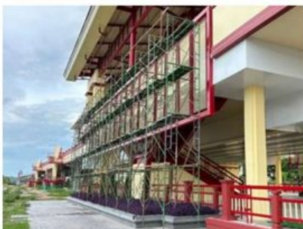
รูปที่ 2-37 การติดตั้งบันได นั่งร้านและราวกันตก
