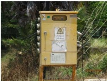
รูปที่ 2-27 ติดตั้งตู้ควบคุมไฟฟ้าในพื้นที่ก่อสร้าง พร้อมการตรวจเช็คอุปกรณ์ไฟฟ้าที่ใช้ในการทำงาน
