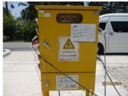
รูปที่ 2-27 ติดตั้งตู้ควบคุมไฟฟ้าในพื้นที่ก่อสร้าง พร้อมการตรวจเช็คอุปกรณ์ไฟฟ้าที่ใช้ในการทำงาน
