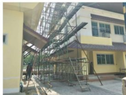
รูปที่ 2-37 การติดตั้งบันได นั่งร้านและราวกันตก
